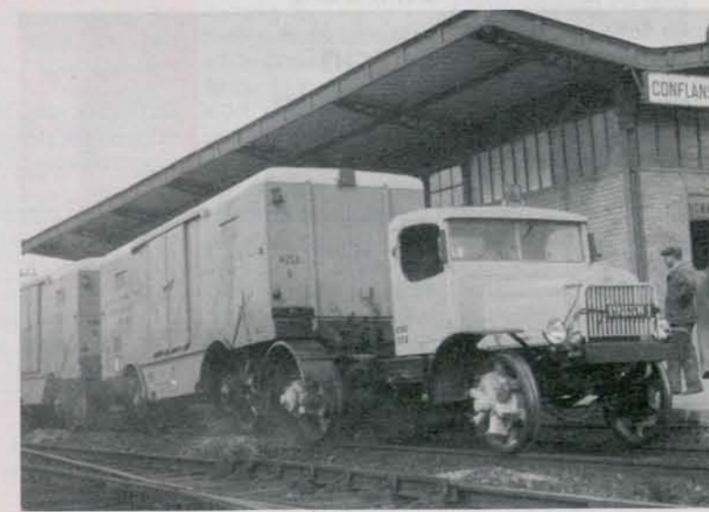
Ci-dessus, un fourgon de déménagement composé d'un châssis « L 10 » et d'une carrosserie « A » avec sa cabine à poste de conduite avancée. Ci-dessous, une version du célèbre tracteur « Liberty » équipé du système « wagon-rail-route » de Willème-Coder, en gare de Conflans-Ste-Honorine, dans les années 30.
