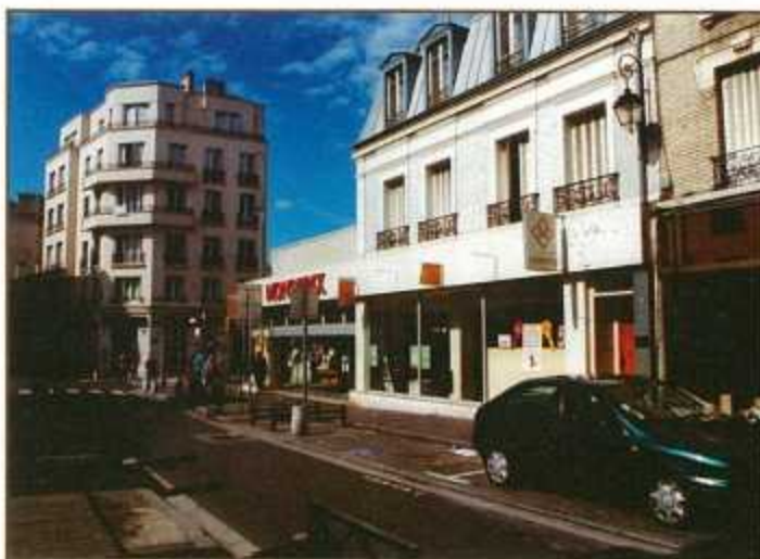
Monoprix occupe le rez-de-chaussée de l'ancienne maison d'habitation de la famille Gauss.
