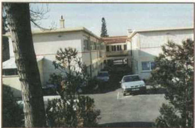
L'aspect actuel de l'ancienne usine, depuis l'avenue Joliot-Curie.
