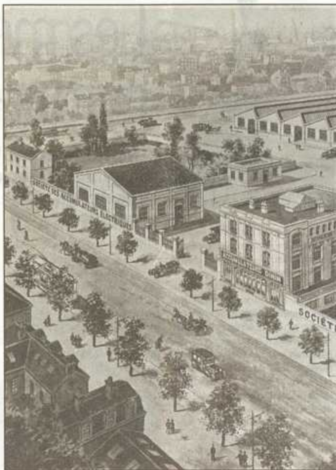
Les usines de Nanterre de la Société des accumulateurs électriques route de Cherbourg (actuelle avenue du Maréchal-Joffre).
