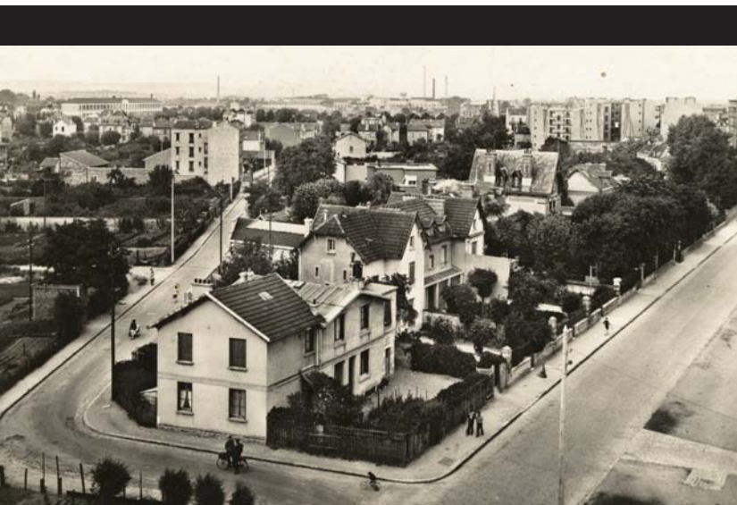
Cet îlot, compris entre l'avenue Henri-Martin (à droite) et la rue de la Chasse, se trouvait à la place de l'autoroute A 86.
