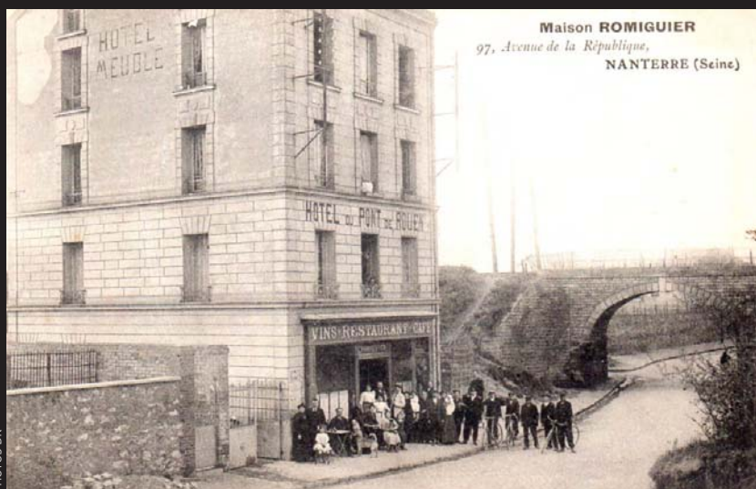
Le pont de Rouen en maçonnerie.
