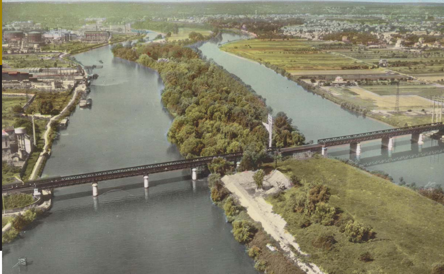
Le viaduc de Bezons reconstruit en 1892, photographie des années soixante. À gauche, Nanterre.
