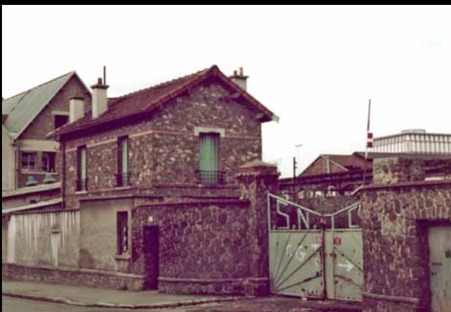
L'entrée des ateliers de la voie, rue Noël-Pons.
