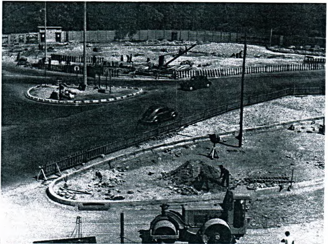
1959, l'aménagement de la place de la Boule après l'ouverture des avenues Lénine et Joliot-Curie.
