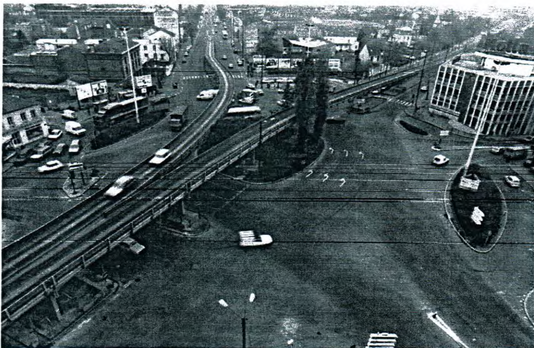
Le toboggan installé en juillet 1971.
