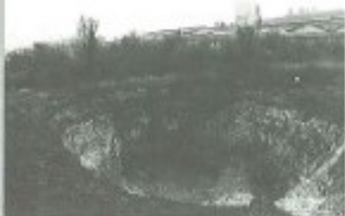
Un exemple d'affondrement de toit d'une carrière souterraine, ici à la carrière du lieu-dit de Moulin à Bulet.
