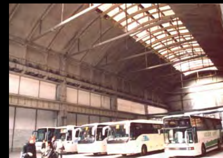
Vue intérieure sur les voûtes.
