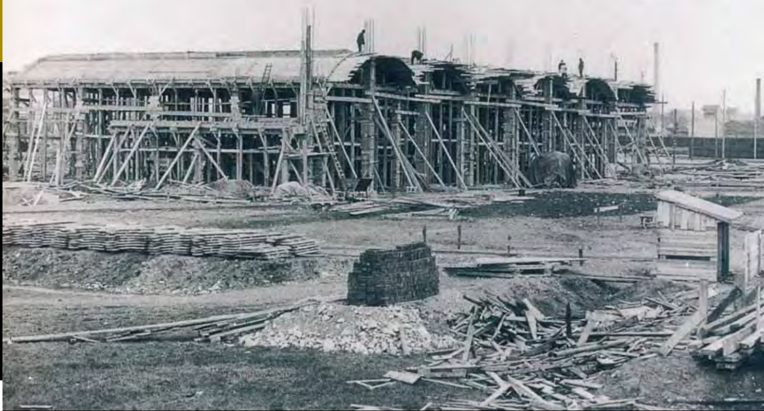
Construction des ateliers du service électrique.
