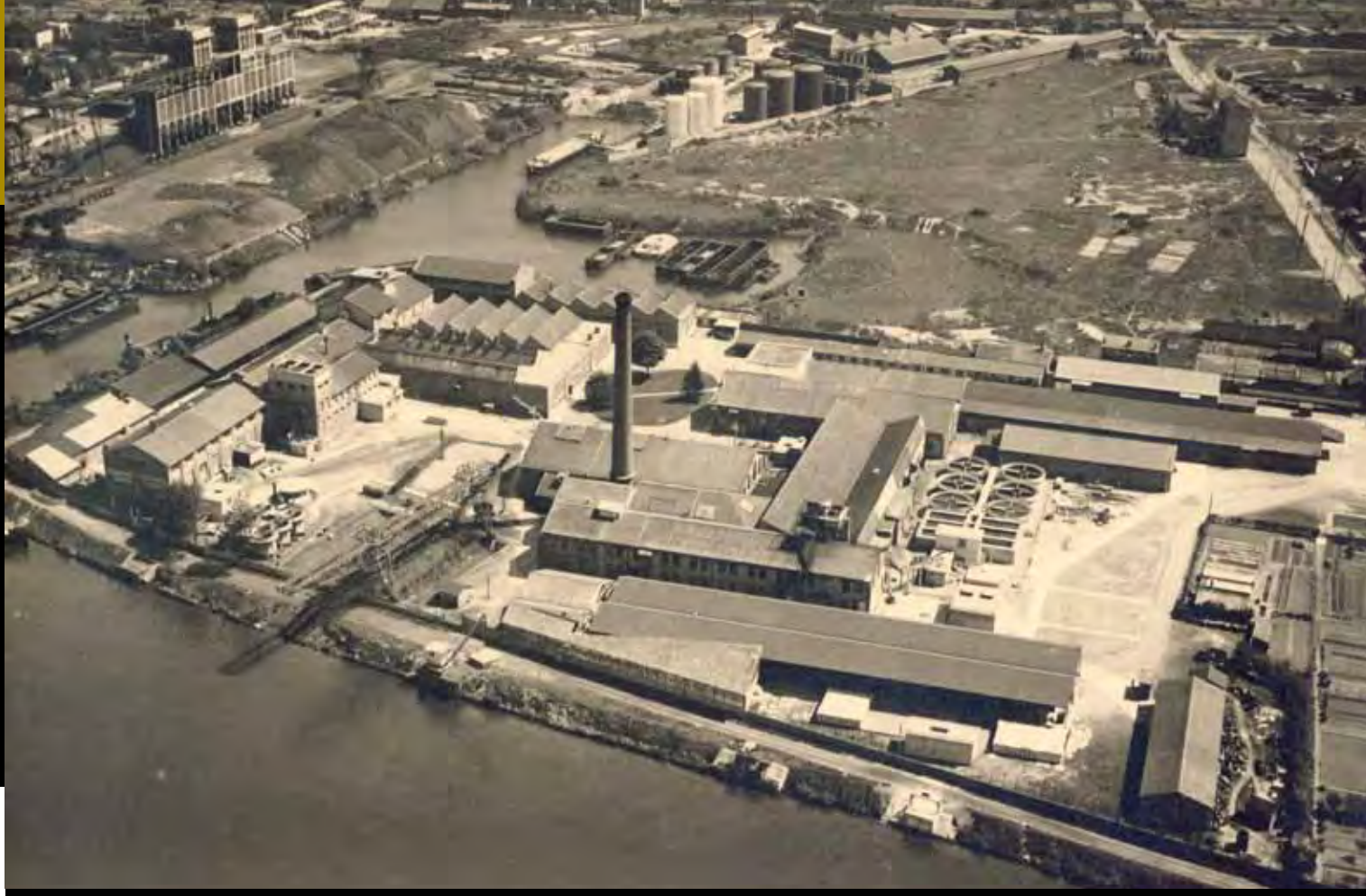
La papeterie de Nanterre, avenue Jules-Quentin (en 1950).
