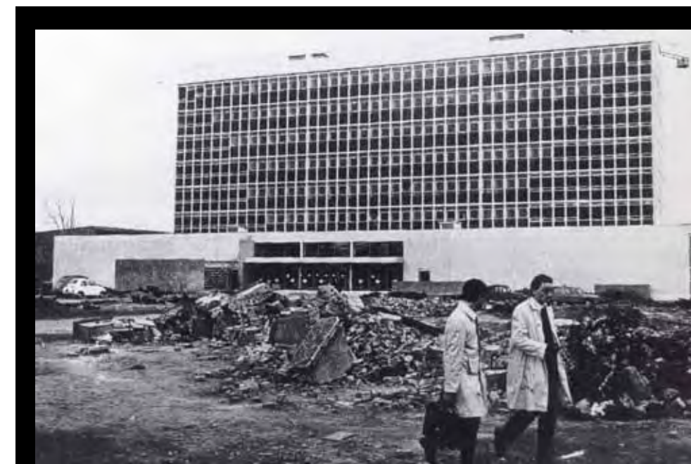
Vue sur le chantier des premiers bâtiments de l'université.
