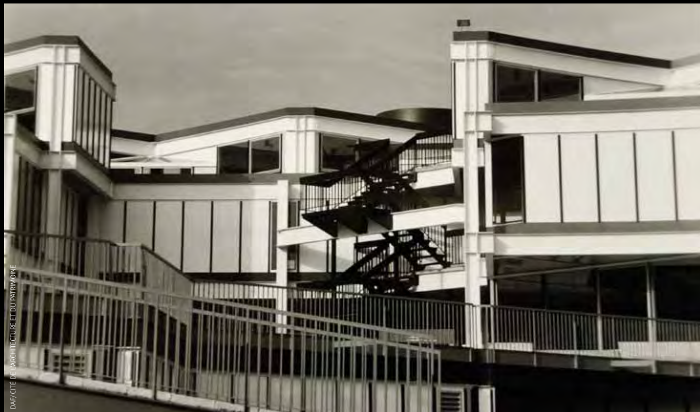
Coursives et passerelles relient les salles et les espaces communs.
