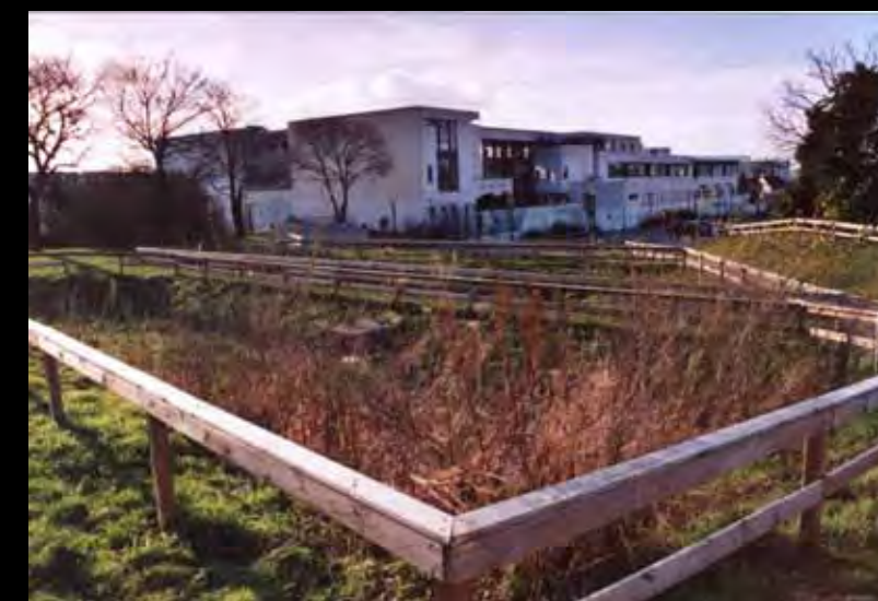
En 2005, la rue de Suresnes a changé d’allure avec l’aménagement du parc des Chêneveux. Ici, le bassin filtrant.
