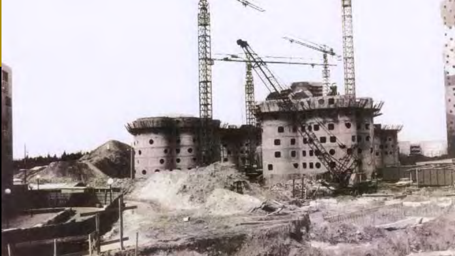
Les tours Aillaud en construction.
