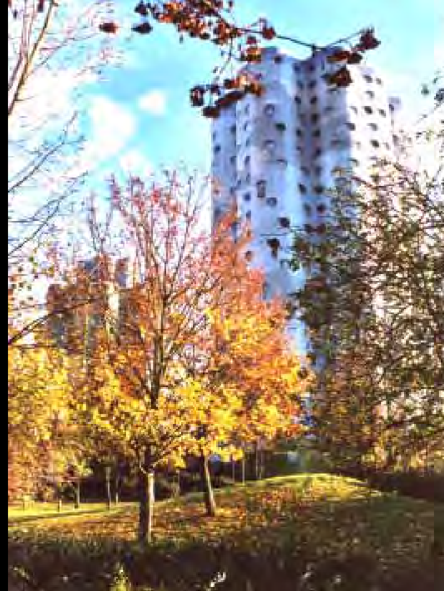
Le modelage du sol et la végétation créent une continuité avec le parc Malraux.
