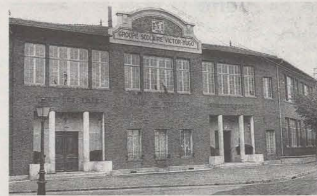
Le collège Victor Hugo, ancienne école primaire construite en 1929.
