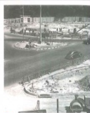
Après la guerre de 1939-1945, les tiers sont construits pour améliorer la route nationale 13 et assurer une liaison Nanterre et les communes voisines. La Boule, l'un rejoint Chatou, l'autre La Garenne. Le premier (l'avenue Joliot-Curie) en 1950, le second (l'avenue Joliot-Curie)
