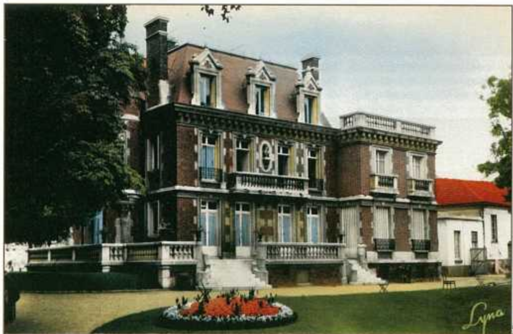
Les agrandissements de 1932 respectent le style du bâtiment ancien : mêmes matériaux (brique rouge et pierre), continuation de la corniche, reprise des encadrements de fenêtres et des balustres.
