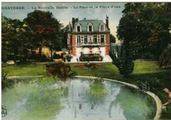
Les serres, à droite de la mairie, seront démolies en 1932.
