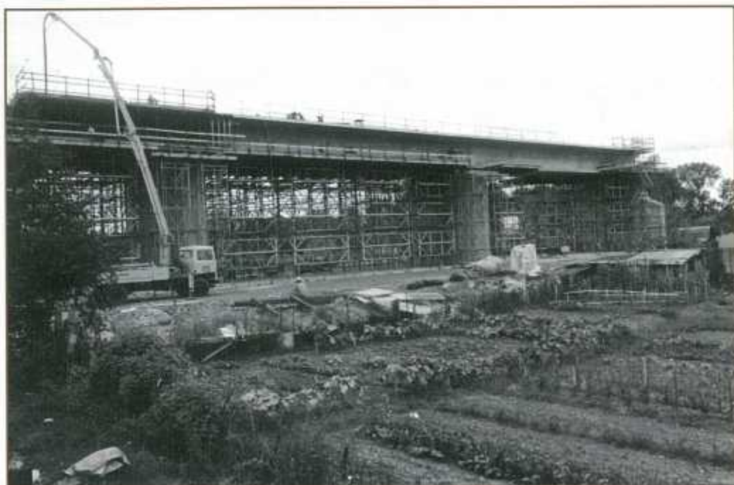
1977, construction du pont de la ligne Cergy-Pontoise et les jardins des papetiers.
