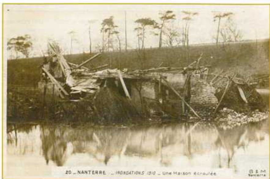
20 - NANTERRE - INONDATIONS 1910 - Une Maison écroulée.
