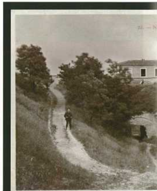
Entrée de la carrière de la Folie.
