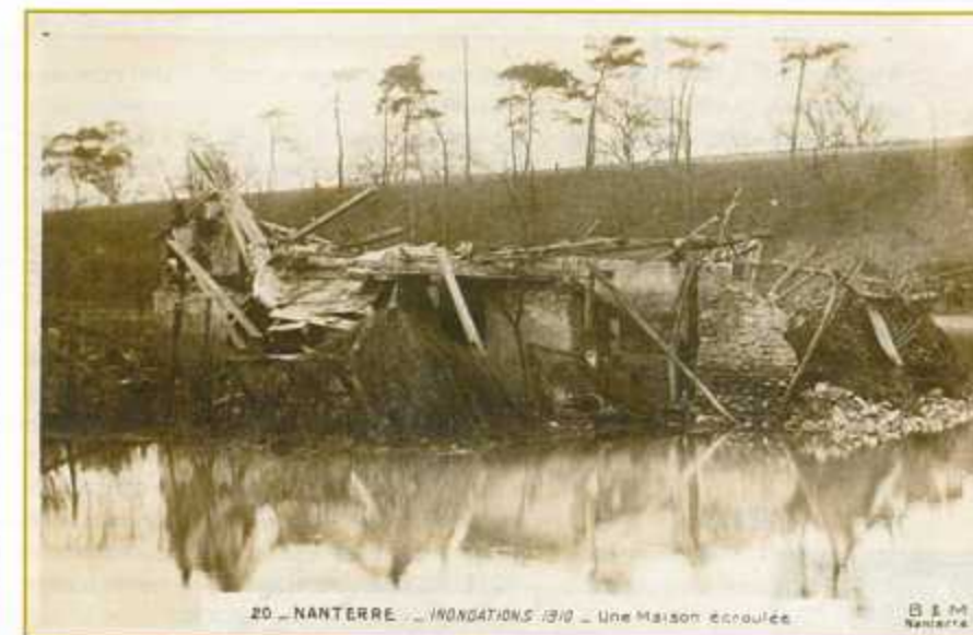
Une maison écroulée, suite aux inondations.
