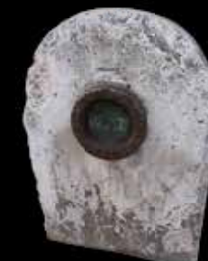
Bornes avec repères de nivellement situées avenue de Rueil et rue Paul-Vaillant-Couturier.
