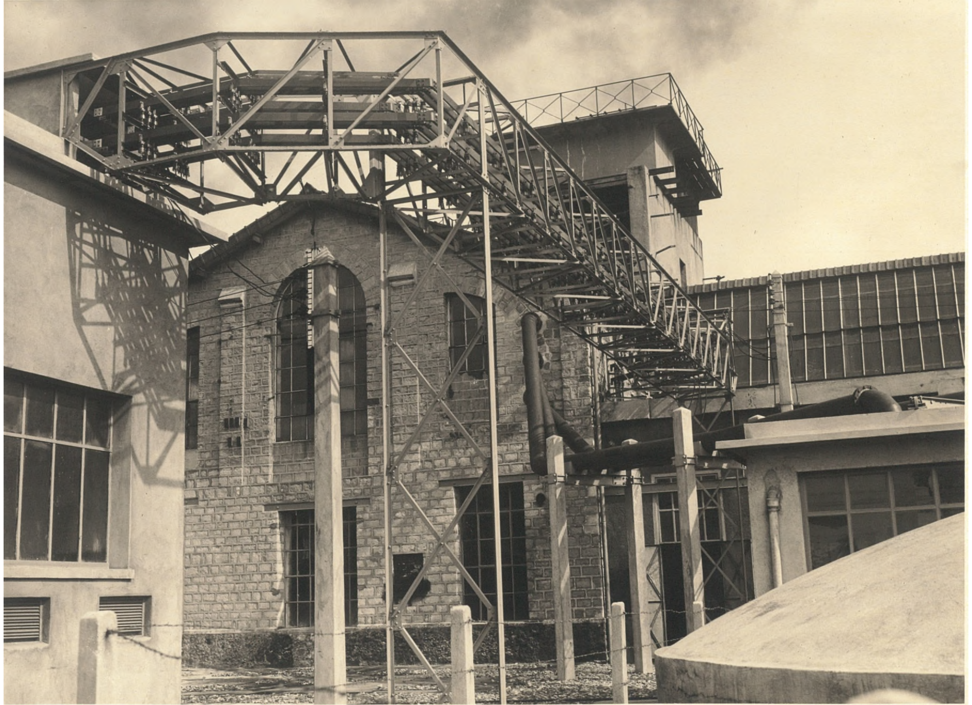
DEPART D'ENERGIE BASSE TENSION N° 2
