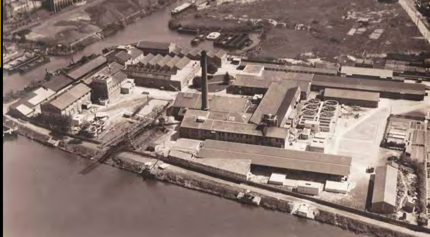
Vue générale de la papeterie. À gauche, sur la photo : l'usine à gaz et la darse qui, depuis, a été comblée.
