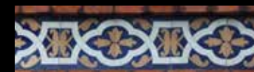
Jeux sur le contraste des couleurs entre les briques et les carreaux au n°19 de la rue de l'Église.
