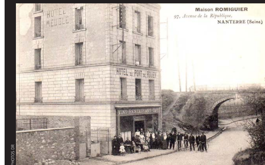
Le pont de Rouen en maçonnerie.
