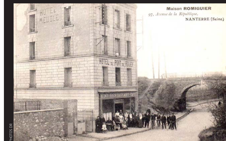
Le pont de Rouen en maçonnerie.
