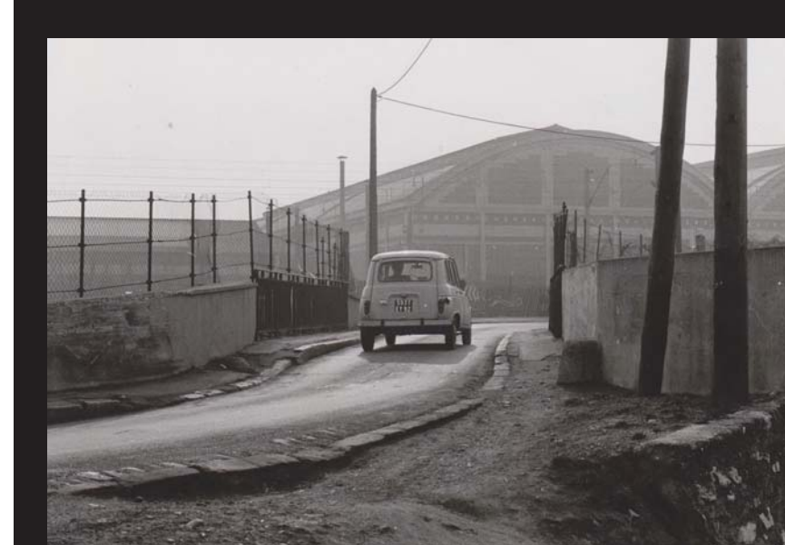
Le pont des Fondrières avant son élargissement.
