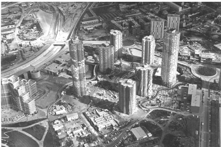
Chantier des tours Nuages de l'architecte Emile Aillaud entre 1973 et 1981.
