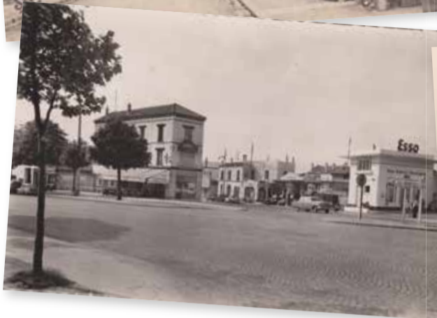
La station-service rue Sadi-Carnot.
