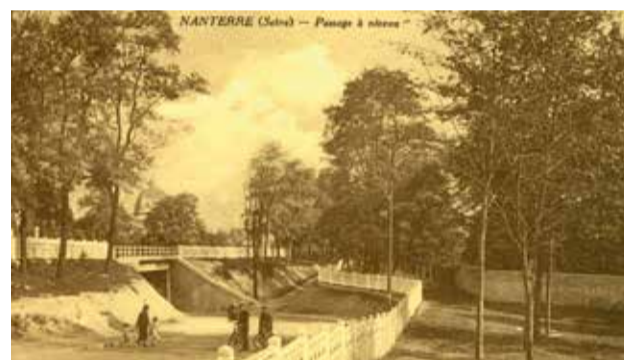
La rue Paul-Doumer remplace le passage à niveau.
