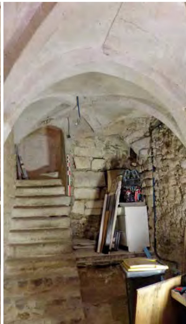
Vue de l'accès actuel à la cave.
