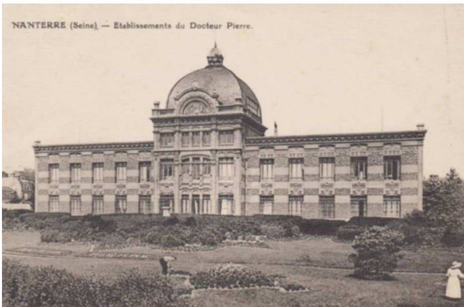
Nanterre, début du XX e siècle. En 1900, les héritiers du Docteur Pierre font édifier ce bâtiment. La marque de produits prénataux Natalys s'y installe en 1973. L'édifice sera classé monument historique en 1992. (DR.)
