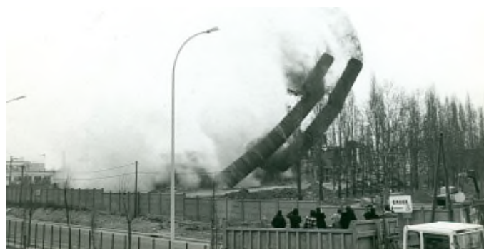
La démolition de «La Rona» en 1982.
