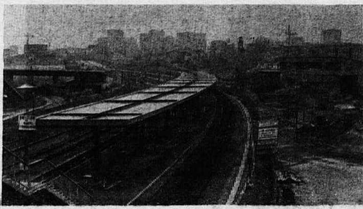
Les travaux avancent à la gare « S.N.C.F. » Défense : ils seront terminés en juin 1968. En attendant, elle est utilisée « provisoirement » pour les Arts Ménagers.
