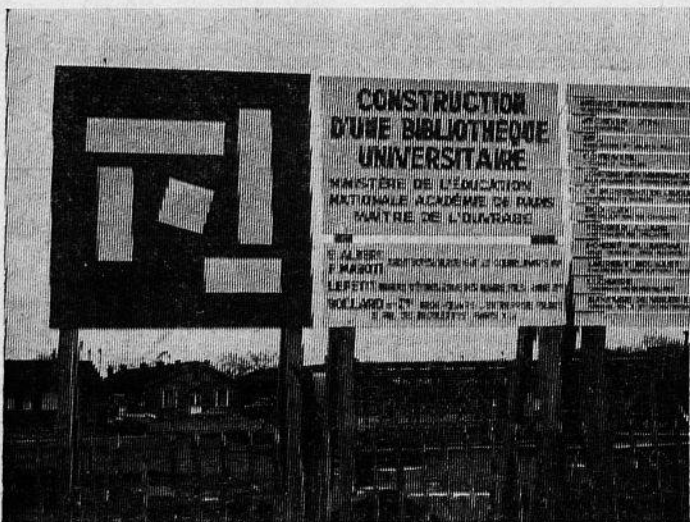
La construction de la bibliothèque commence. Le projet date de près de quatre ans.
