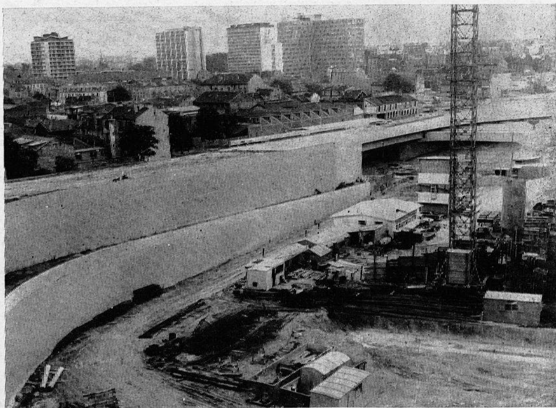
« La construction de la voie périphérique ».
