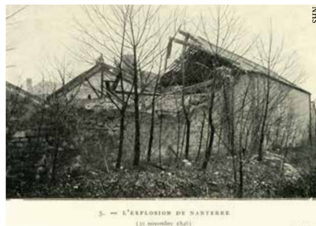
Les dégâts après l'explosion.
