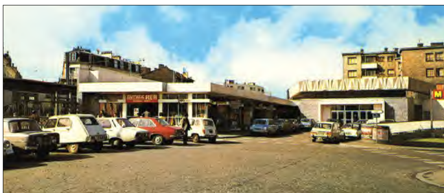
La gare de Nanterre-Ville et sa galerie marchande du côté de la rue Béranger.
