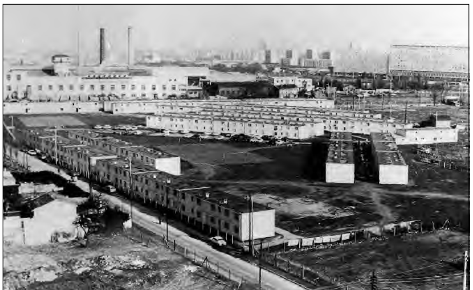
Le viaduc doit traverser une partie de la cité Blanche au niveau de la rue Gutenberg. Plusieurs familles seront évacuées et relogées.
