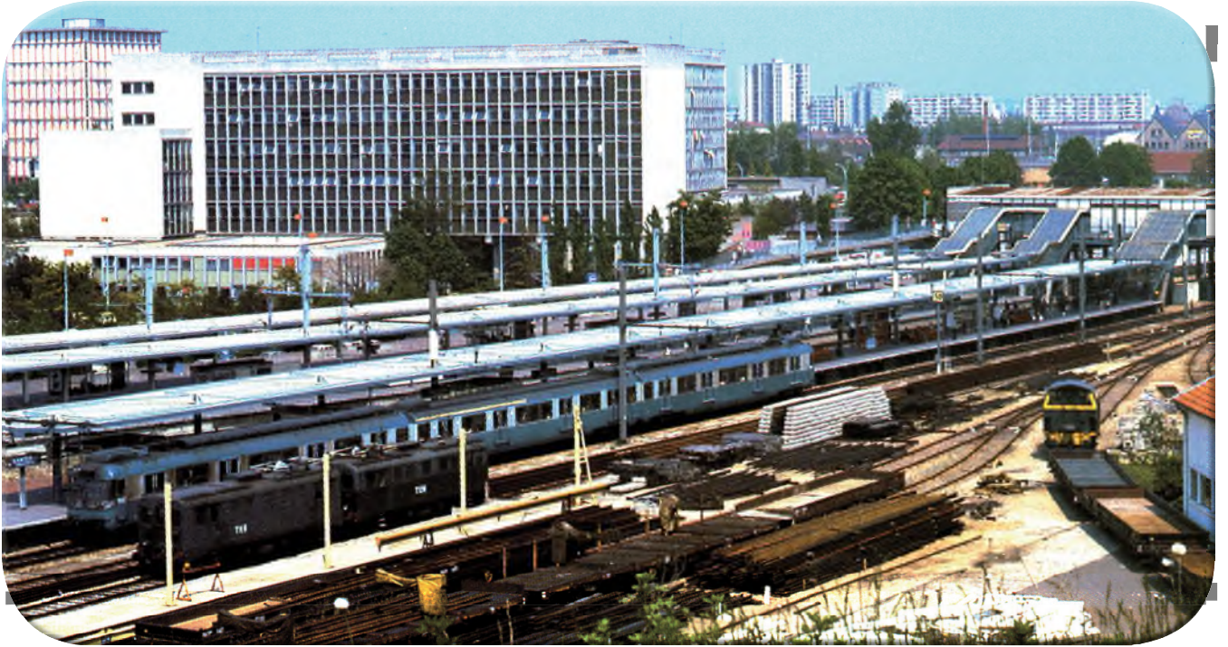
La gare provisoire de Nanterre-Université, comprise entre les ateliers RATP et l'université, restera en place de 1972 à 2015.
