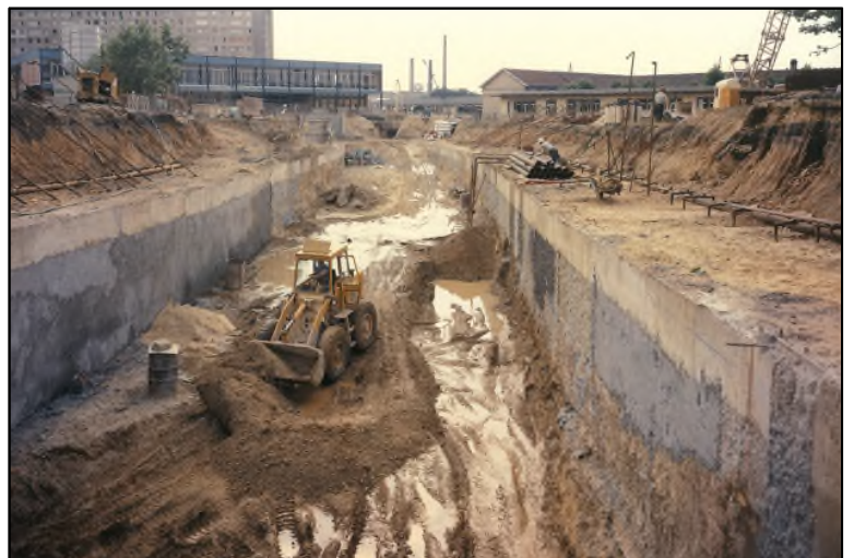
La tranchée du RER traverse l'université en direction du restaurant universitaire (bâtiment bleu) et de l'école du Petit-Nanterre (à droite). Sa construction sera arrêtée en raison de l'abandon du projet de gare P avenue de la République.
