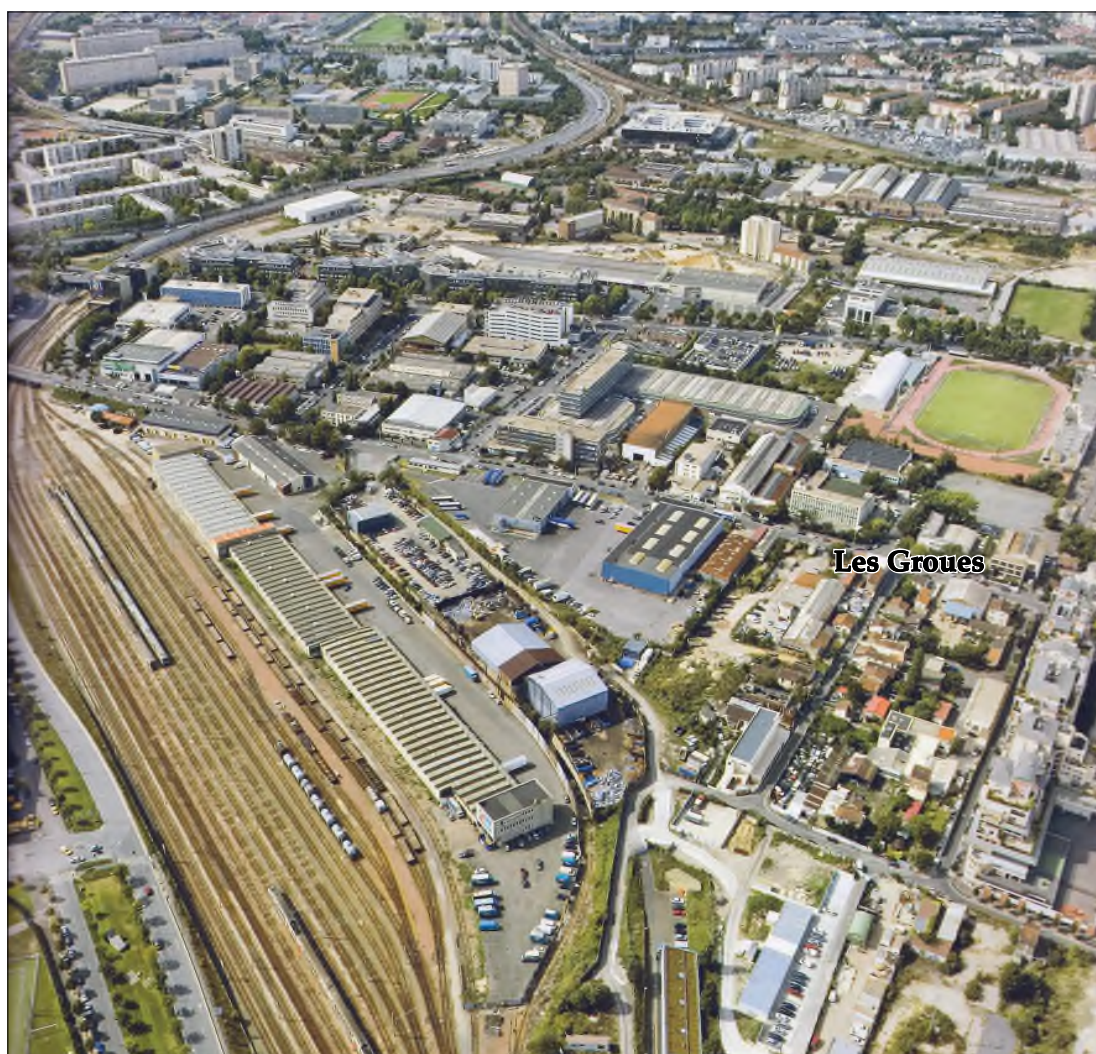
Vue aérienne montrant le faisceau de la gare de marchandises et ses entrepôts, le quartier des Groues et entre le boulevard Arago et les ateliers de La Folie, un territoire qui mêle les locaux des centres de formation SNCF, des entrepôts, une déchetterie, des terrains en friche. Au fond à droite, le Petit-Nanterre.
