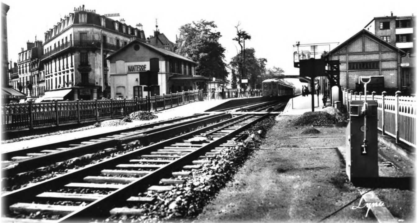
La gare de Nanterre et un Standard, avant les travaux.
