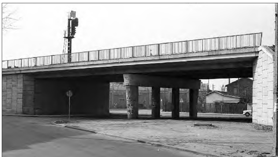
Le pont de Biais élargi. (Photo JRC)
