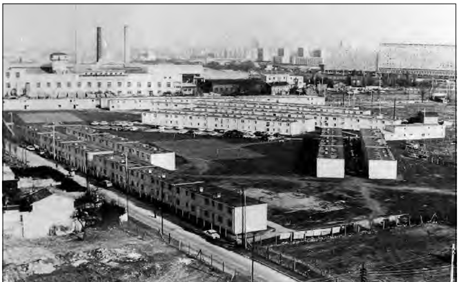
Le viaduc doit traverser une partie de la cité Blanche au niveau de la rue Gutenberg. Plusieurs familles seront évacuées et relogées.
