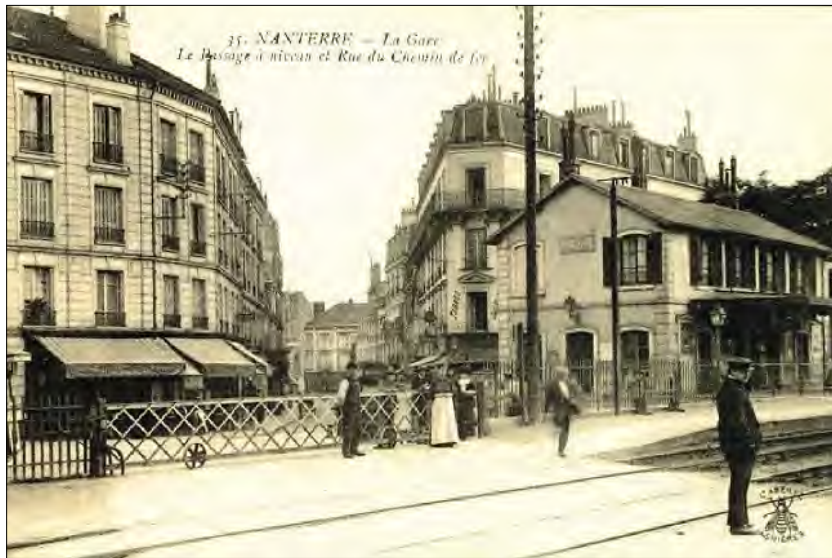
◀ Le passage à niveau, situé près de la gare, permet de rétablir la circulation entre le bourg et la route de Bezons (cliché 1900).
