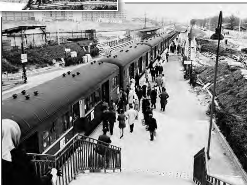
■ Un des trains Standard, qui dessert la ligne Saint-Lazare / Saint-Germain-en-Laye, en gare de La Folie-Complexe universitaire. (fonds BDIC)
