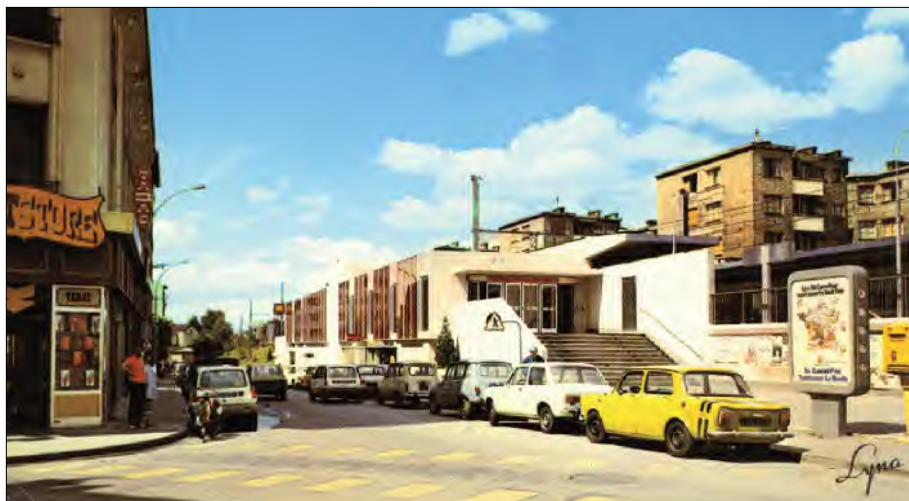
Le nouveau bâtiment de la gare de Nanterre-Ville et le boulevard du Couchant.
