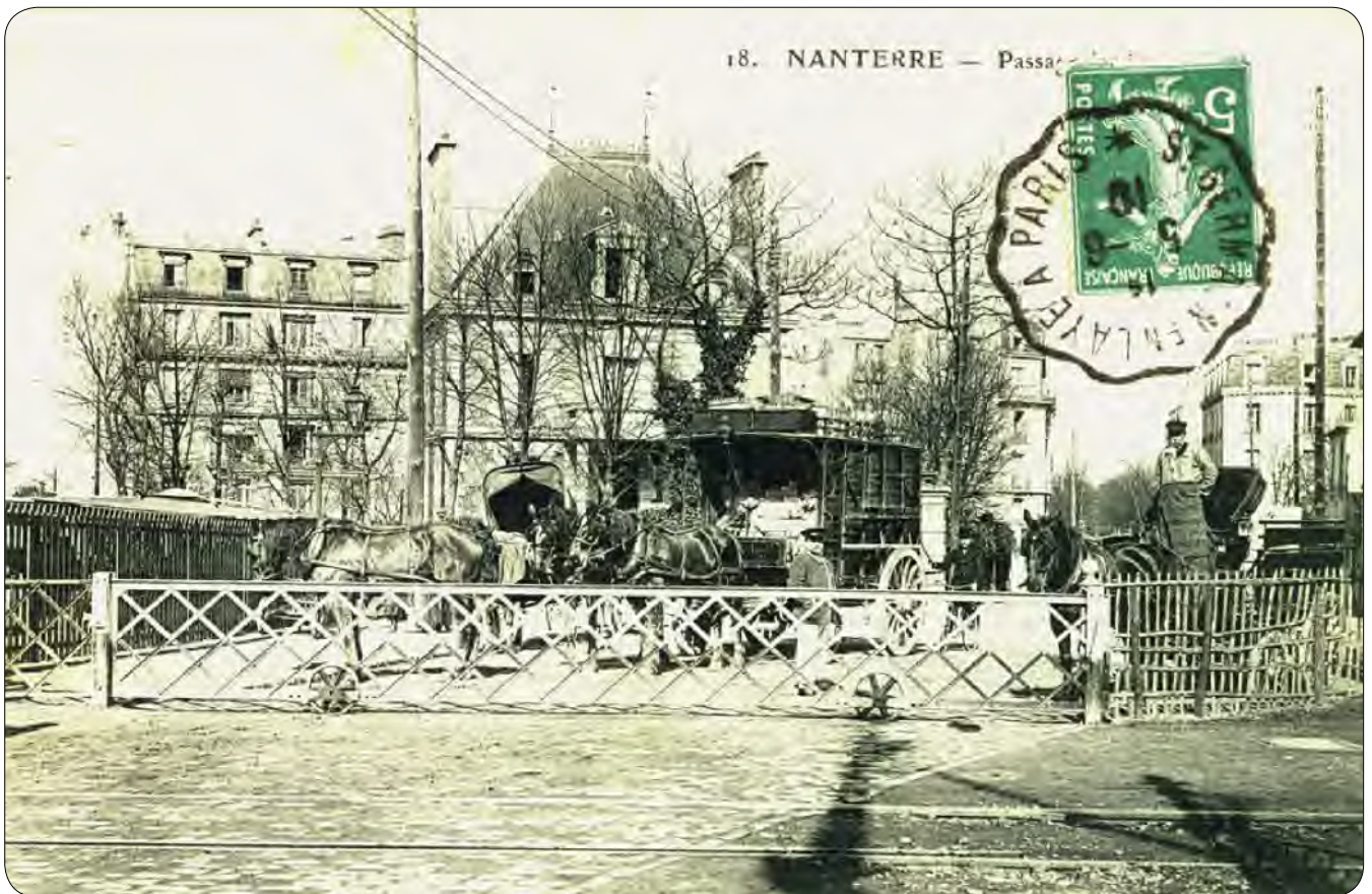
La fermeture prolongée du passage à niveau crée de longues attentes.
