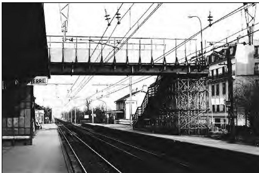
Une passerelle provisoire est réalisée au-dessus des caténaires, en attendant la construction du passage sous les voies. (Photo JRC)
