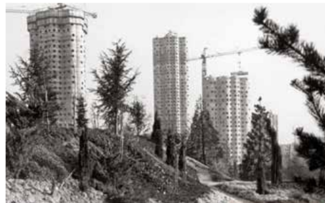
Les tours en construction.
