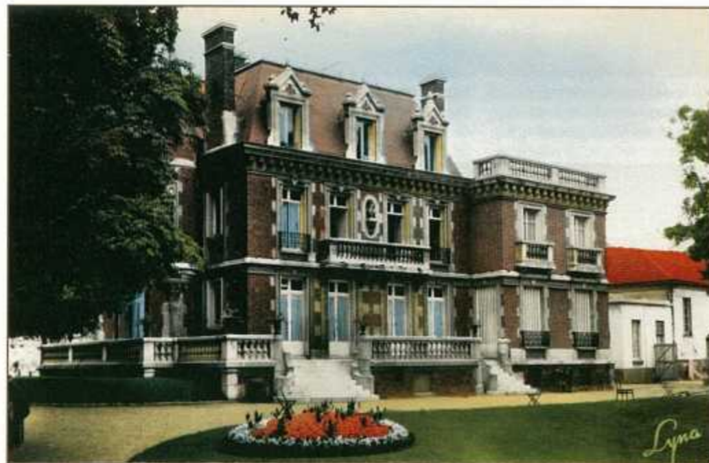
Les agrandissements de 1932 respectent le style du bâtiment ancien : mêmes matériaux (brique rouge et pierre), continuation de la corniche, reprise des encadrements de fenêtres et des balustrades.
