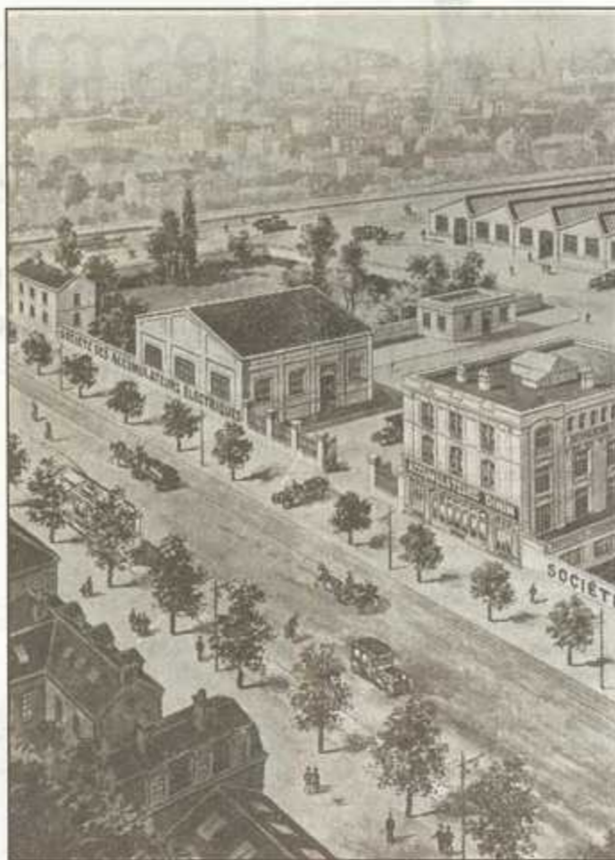
Les usines de Nanterre de la Société des accumulateurs électriques route de Cherbourg (actuelle avenue du Maréchal-Joffre).
