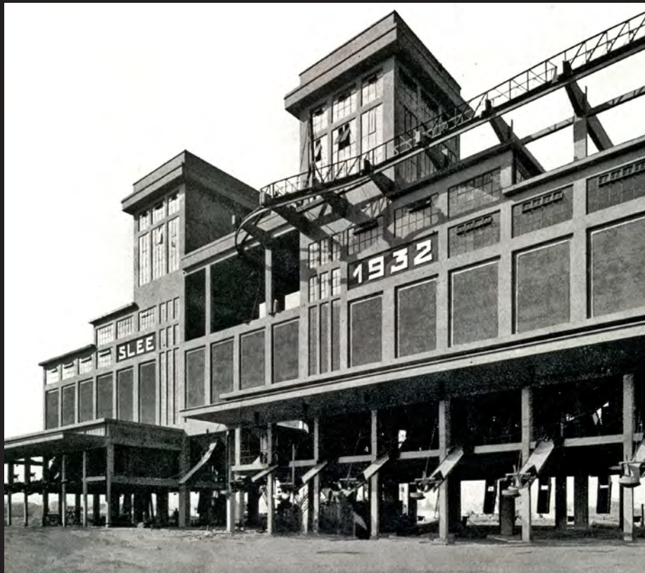
Usine à gaz: vue sur l'atelier de triage et de criblage du coke.
