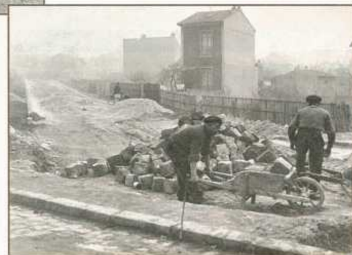
Travaux rue Philippe-Triaire, quartier du Mont-Valérien, en 1938.
