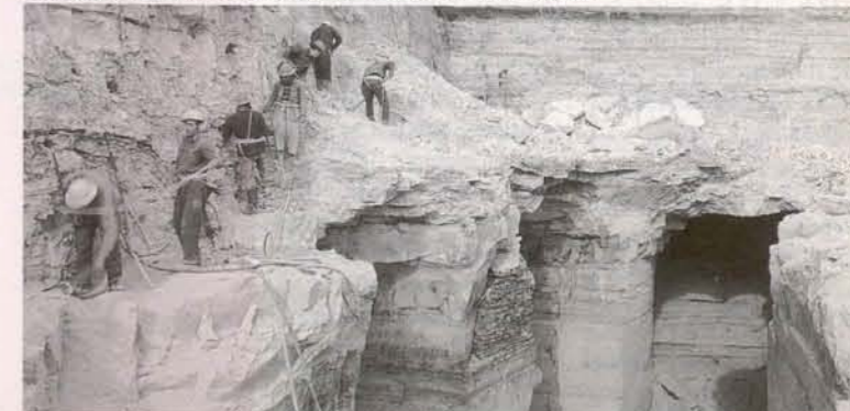
Construction du RER dans la carrière Pascal
