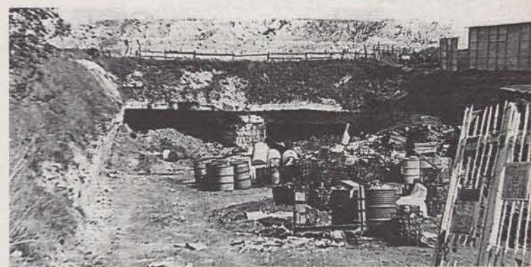
Une entrée de champignonnière, rue de Courbevoie. Au dessus, un talus de terre provenant des travaux du métro express régional (avril 1969).
