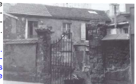
La « maison des voleurs », 247 avenue Clemenceau en 1975.
