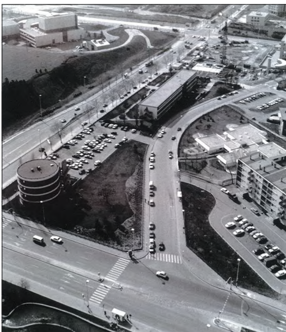
Préfecture provisoire et début de la construction des Archives départementales en arrière-plan - 1977
