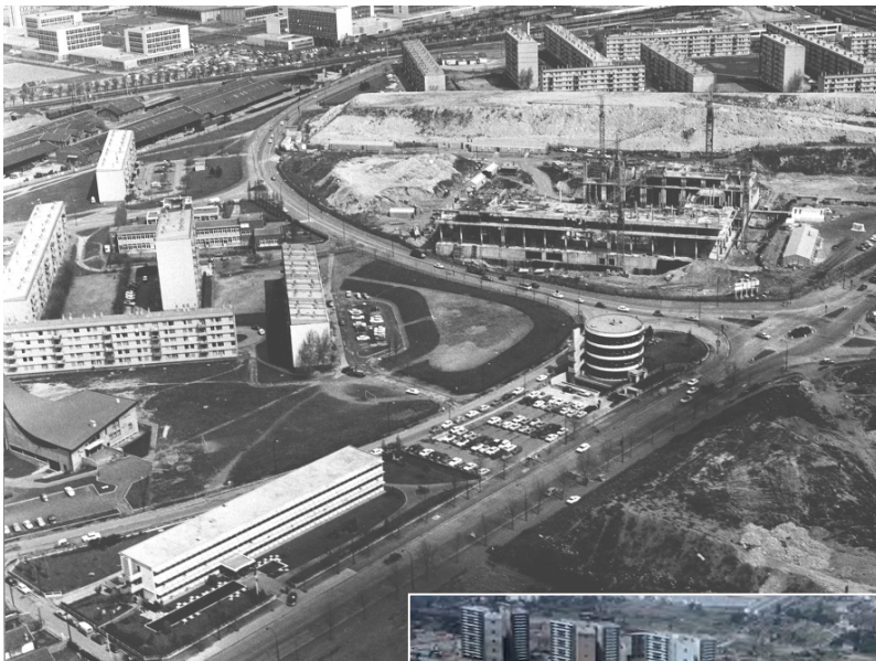
Bâtiment provisoire et construction de la Préfecture en 1970
