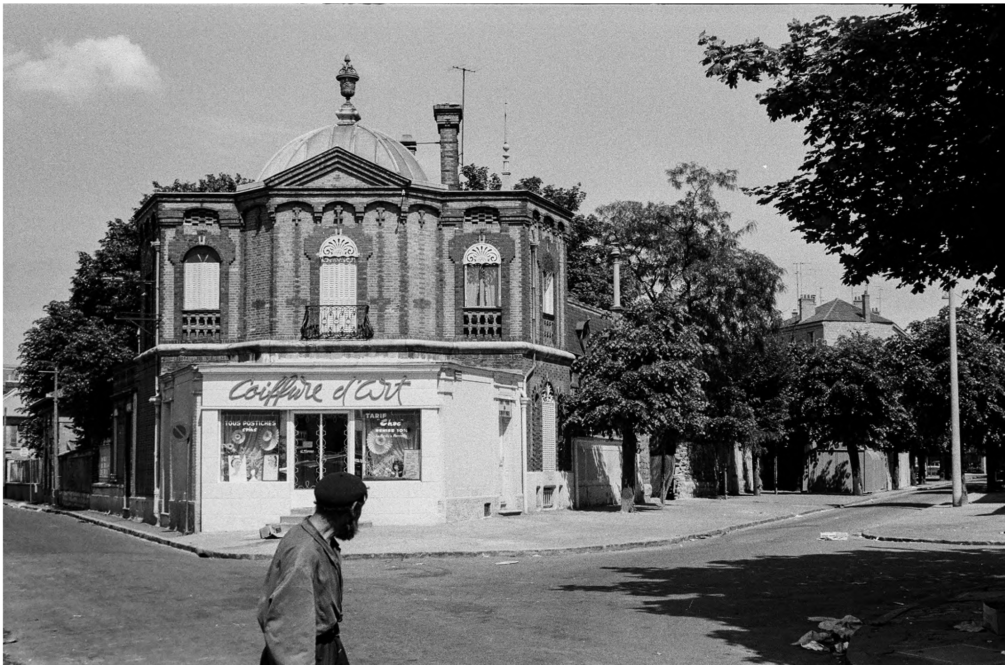
Salon de coiffure à l'angle de la rue du Castel-Marly et du boulevard du Sud-Est.
